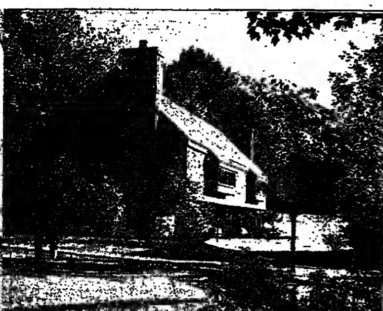
Actual photo of Cluster Homes.
